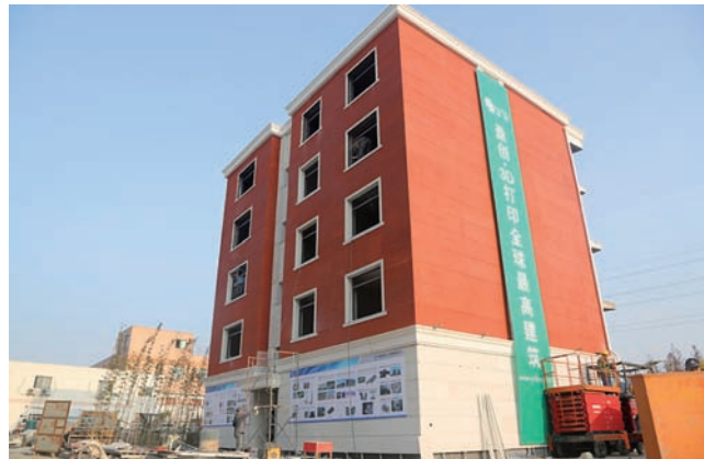
Päťpodlažný bytový dom vyrobený pomocou 3D tlačiarne (Zdroj: winsun3d)
